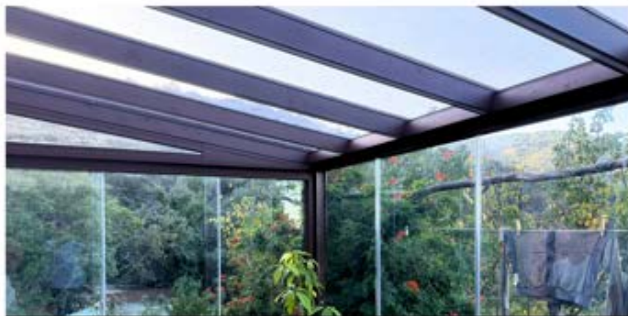
COPERTURA POLICARBONATO COMPATTO
