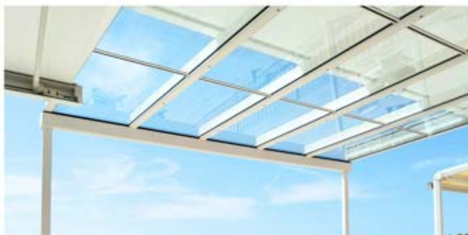
COPERTURA IN VETRO
