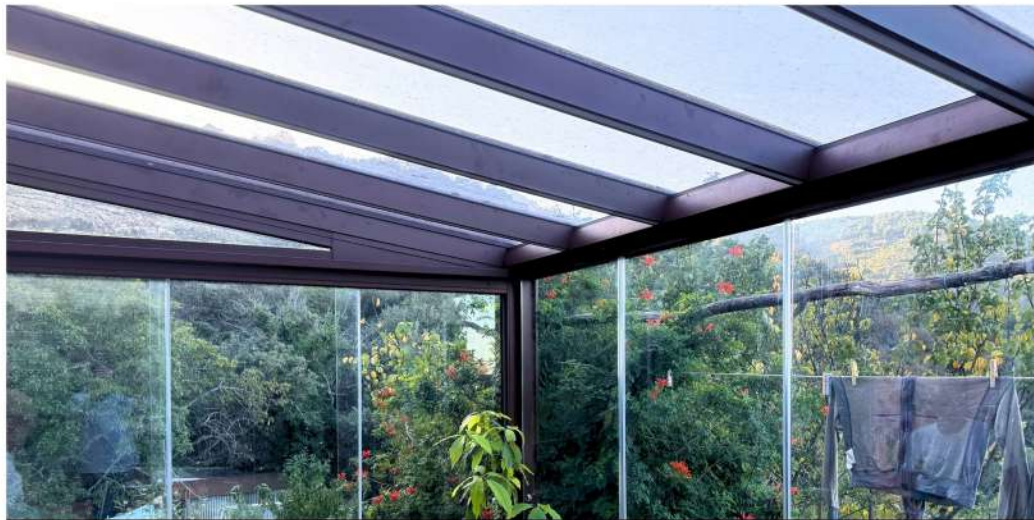
COPERTURA POLICARBONATO COMPATTO
