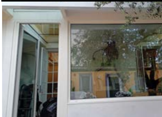
PORTE E FISSI MINIMAL
